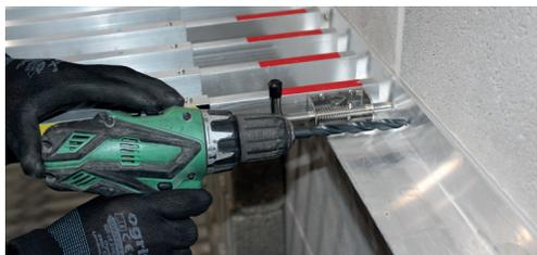
Il est recommandé de prévoir un trou de 12 mm pour les goupilles de positionnement.
