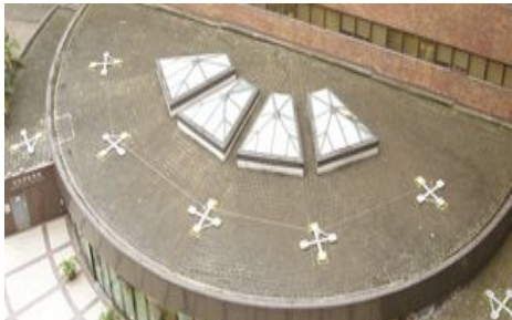
Ligne de vie autoportant
