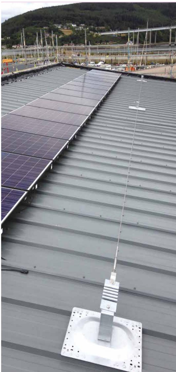
Le système de ligne de vie horizontale **KEELINE** a été conçu pour garantir un accès sécurisé à toute zone d'une toiture en permettant aux ouvriers d'être constamment attachés et ainsi de pouvoir librement se déplacer sur la toiture. Ce système intègre un câble de 8 mm de diamètre en acier inoxydable 316, offre des portées maximales de 12 m entre chaque potelet et peut être utilisé par 3 personnes à la fois.
